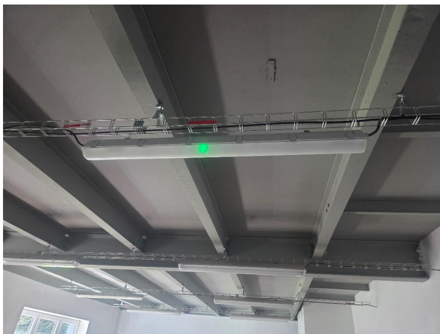
ÚV Příkrý – výměna nouzového osvětlení
